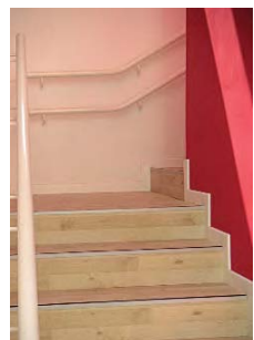
Repérage au sol de l'escalier et nez de marches contrastés à la Cité des sciences et de l'industrie.
