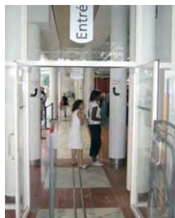
Large portillon, sol en marbre avec lignes guides, à l'entrée de la bibliothèque de l'Alcazar à Marseille.
