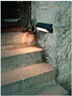
Éclairage rasant participant au guidage dans un escalier à vis au Mont Saint-Michel.
